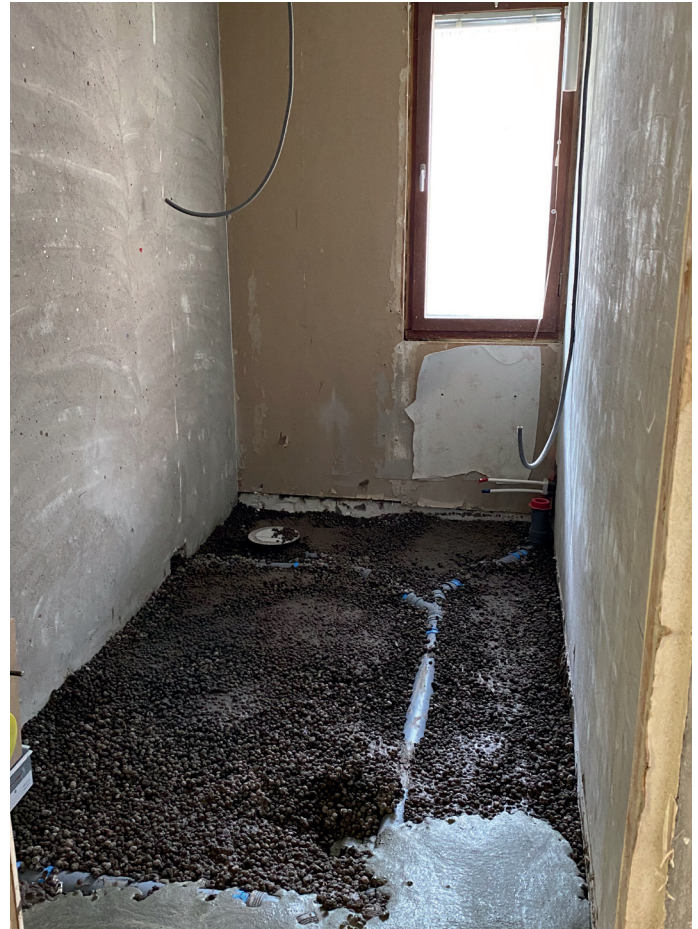
Ett badrum under byggtiden
