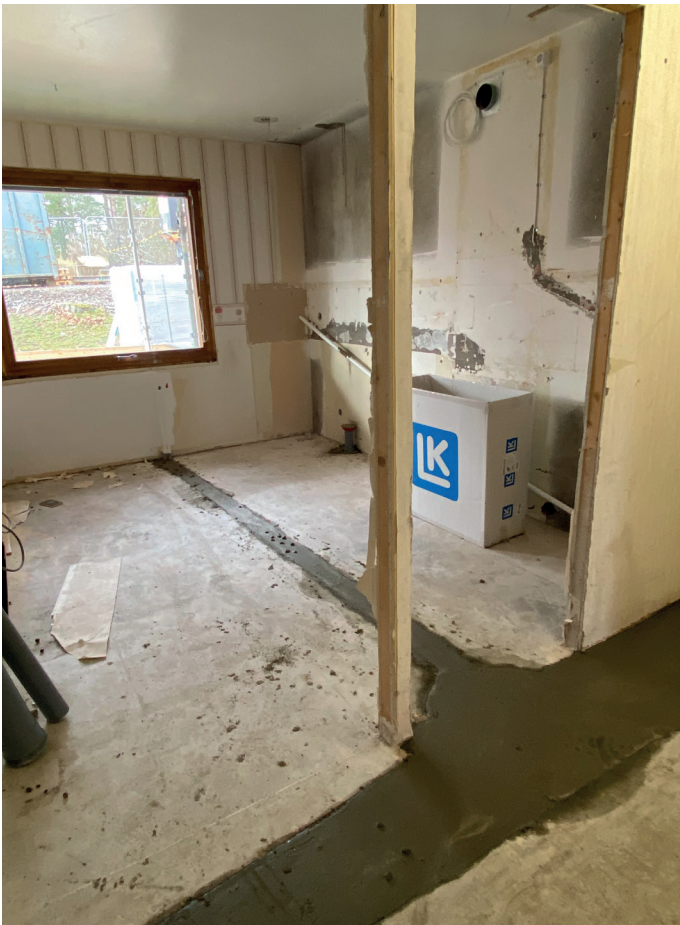
Ett kök under byggtiden
